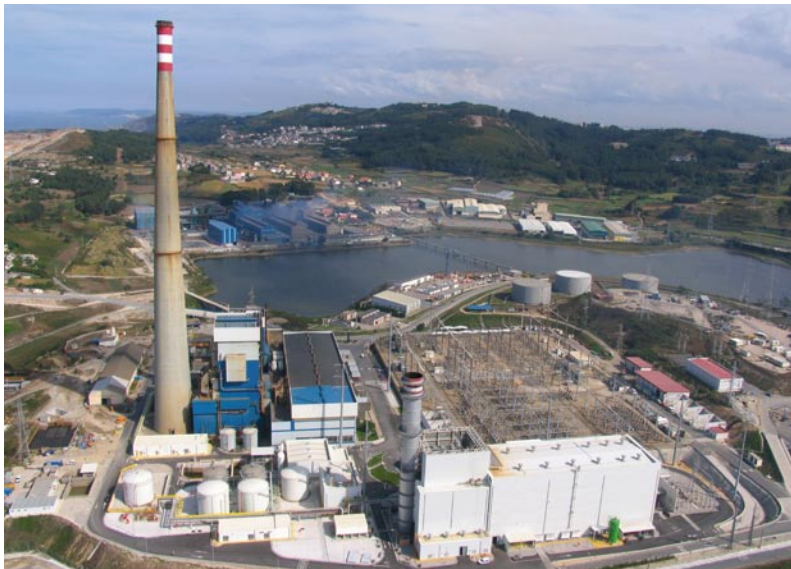
➤ Central Térmica de Ciclo Combinado Sabón (España)
